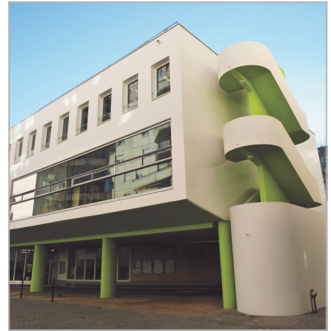
La façade de l'école Desnos a été entièrement rénovée.
