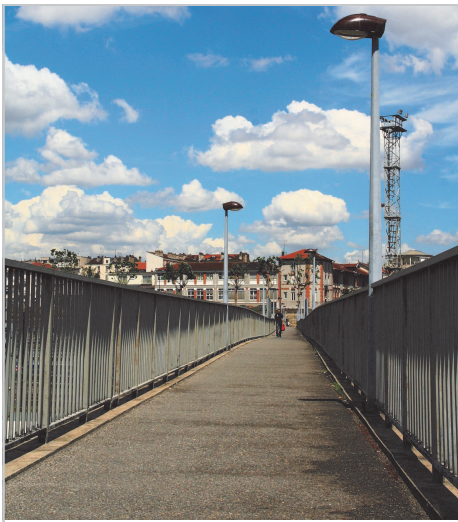
La passerelle reliant Bercy à Valmy est, à ce jour, le seul moyen de traverser les voies de chemin de fer
