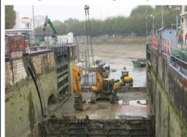
Joinville-le-Pont, octobre 2015. La vanne a été retirée. Quand elle fonctionnera, elle permettra de limiter de 40 cm la montée de la Marne en cas de crue. (L'YEM)
